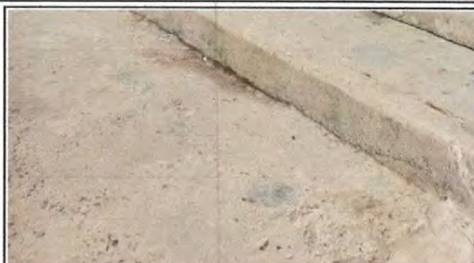
Foto 2: PISO. REPARACIÓN DE PISO TORTA DE CONCRETO. LADO DERECHO DEL AULA DE QUINTO Y SEXTO.
