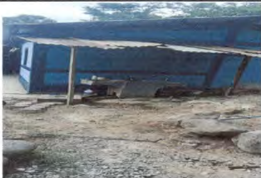
Foto 7: REPARACIÓN DE COSINA. SUSTITUCIÓN DE PILA DE DOS LAVADEROS, SUSTITUCIÓN DE LAMINA POR LAMINA ALUZINC CALIBRE 26.
