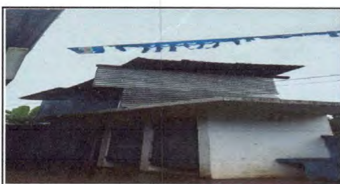
Foto 6: REPARACIÓN Y MANTENIMIENTO DE SISTERNAS/DEPOSITOS DE AGUA. PROTECCIÓN DEL ROTOPLAS CON CUBIERTA DE LAMINA ALUZINC.
