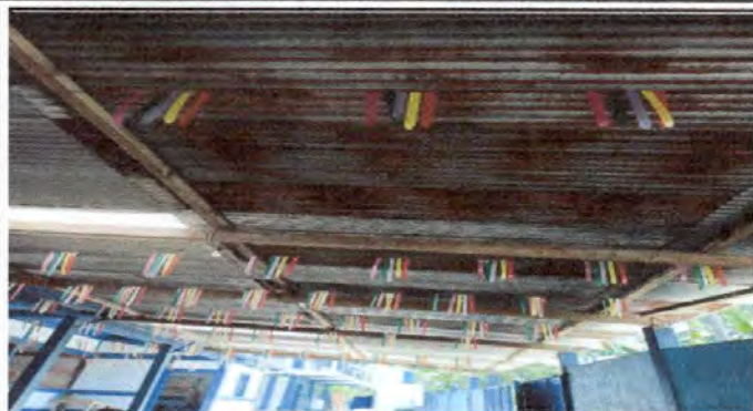
Foto 1: CUBIERTA DE LAMINA. ENTECHADO DE LAMINATROQUELADA Y ESTRUCTURA METALICA EN EL PATIO ENTRADA PRINCIPAL DE LA ESCUELA.
