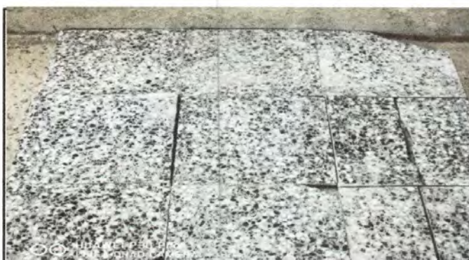
Foto 4: REPARACIÓN O SUSTITUCIÓN DE AZULEJOS. SUSTITUCIÓN DE AZULEJOS POR CERAMICO EN EL PATIO PARTE DE ENFRENTA DE LA ESCUELA.
